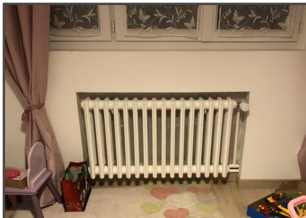
Coffrage pour l'isolation du mur intérieur
